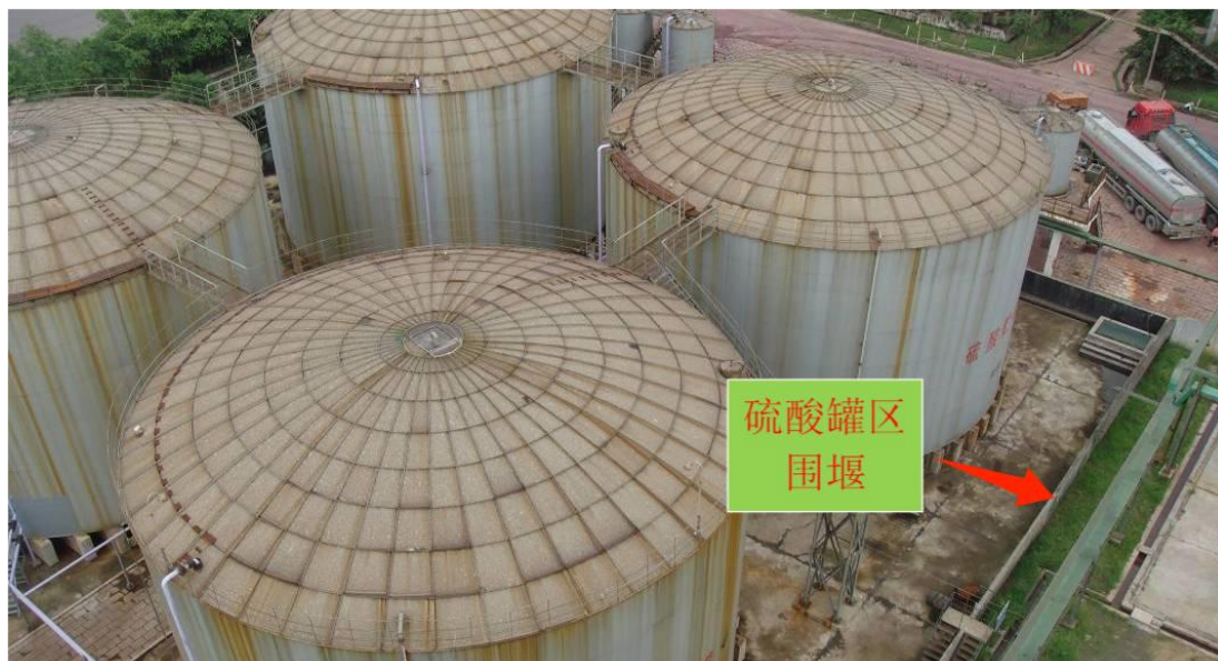
图 3.2-14 硫酸罐区围堰
