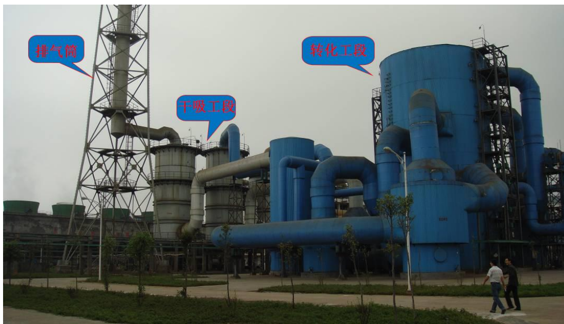
图 3.2-7 转化吸收工段废气处理系统
