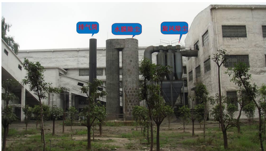
图 3.2-5 原料工段干燥废气处理系统已
