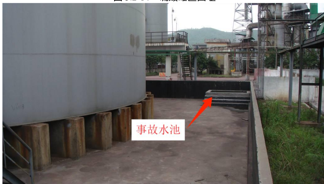
图 3.2-15 硫酸成品罐区事故水池
